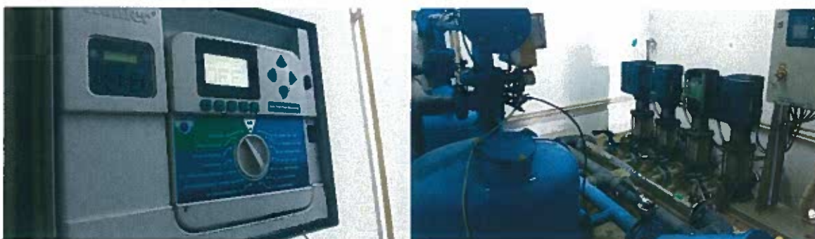
Pormenor da casa das máquinas
