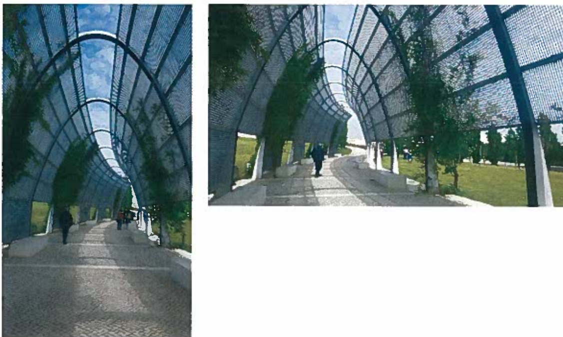
Estrutura metálica que serve de atravessamento e ensombramento, com bancos.
